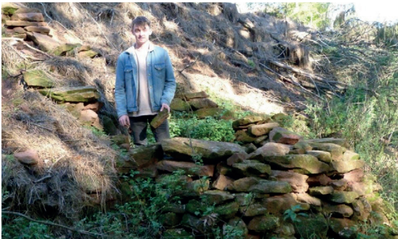
Frederik Weber beim Trockenmauerbau (Foto: Weber)
