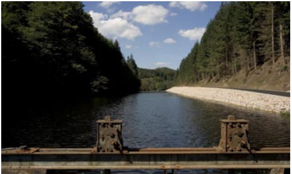
Wasserversorgung Eisenindustrie Jägertal
